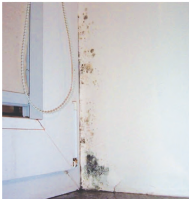
Пліснява на привіконних зонах, що є результатом недостатньо ефективної вентиляції та неправильно сформованого вузла примикання віконної конструкції до стінового отвору
